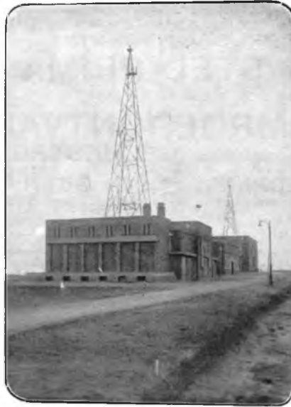
Zendgebouw en antenne-torens
